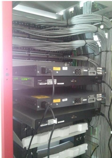
**Figura 5. Detalle de los conmutadores y del cableado (parte trasera)**
